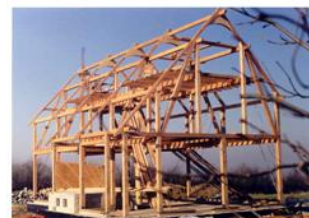
Les longrines relient entre elles les fermes de charpente
