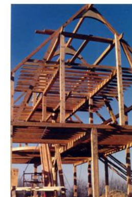
Les longrines relient entre elles les fermes de charpente
