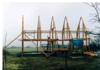
→ Construction de l'ossature sur deux niveaux
