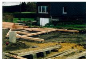
→ Montage de la première ferme de charpente
