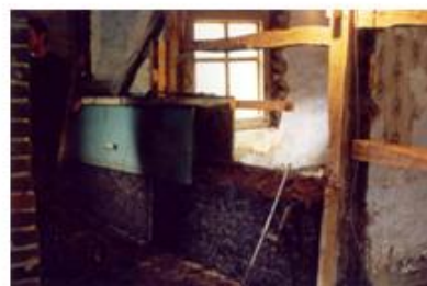
Terre - Paille - coffrage
