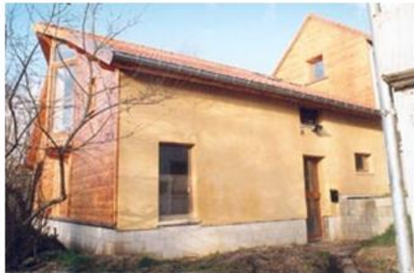
Panneaux de façade enduits à la chaux pour une meilleure intégration urbanistique
