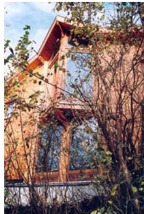
Bardage extérieur en bois
